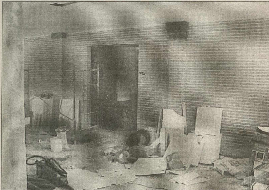
La entrada principal da al Pabellón de la calle Valdepeñas.
