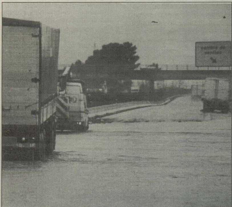
Con el cambio de rasante se eliminarán las balsas de agua en este punto.
