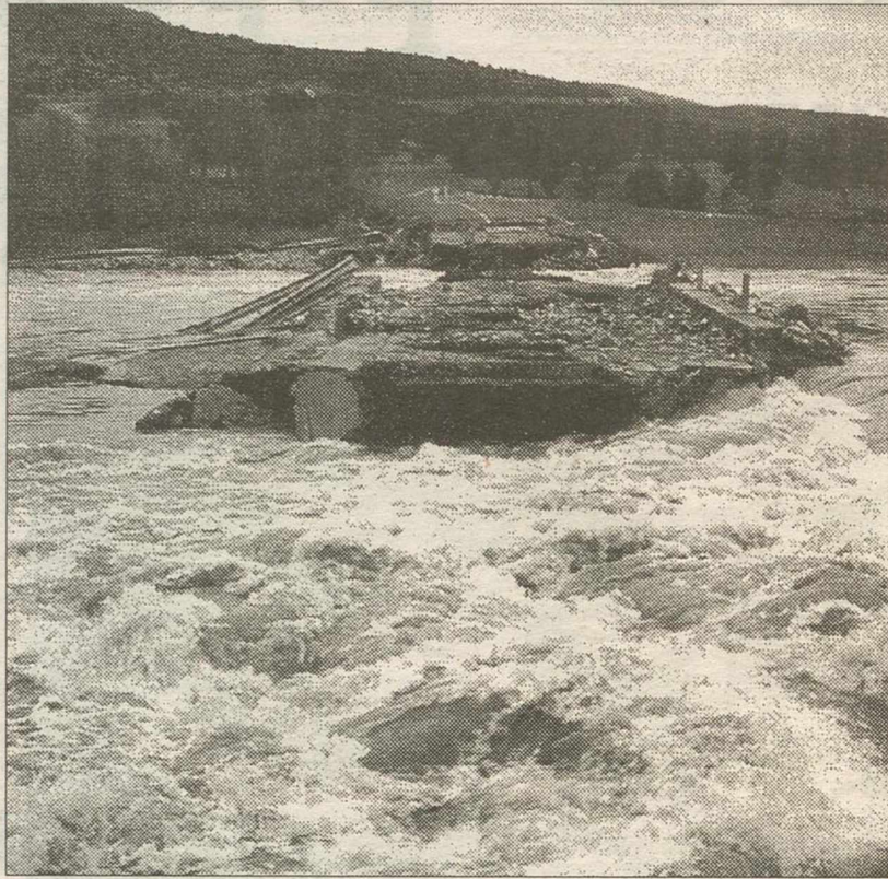
El río se ha llevado parte del puente de Puebla de Don Rodrigo.
