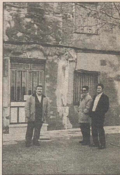
Aspecto que presenta la fachada.
