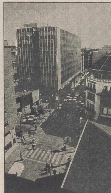
Edificio de Servicios Múltiples.
