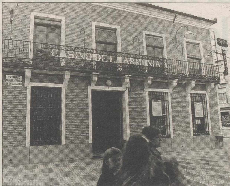
El Ayuntamiento se hará cargo de las obras de remodelación del Casino.
