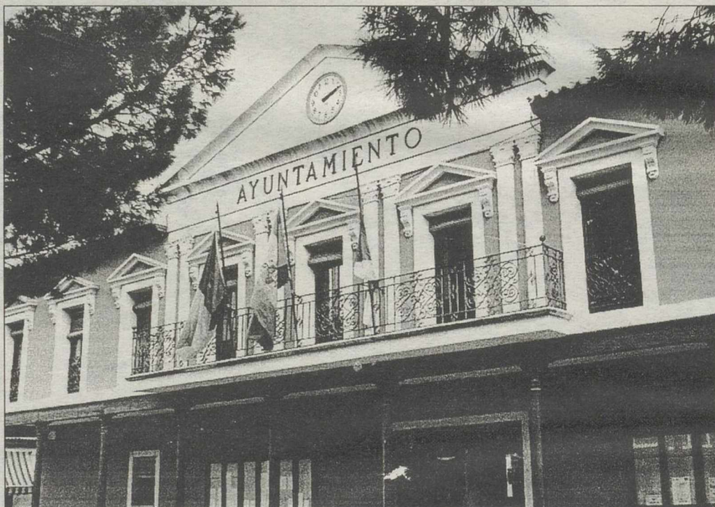
Daimiel está muy bien dotada en infraestructuras, según el alcalde.
