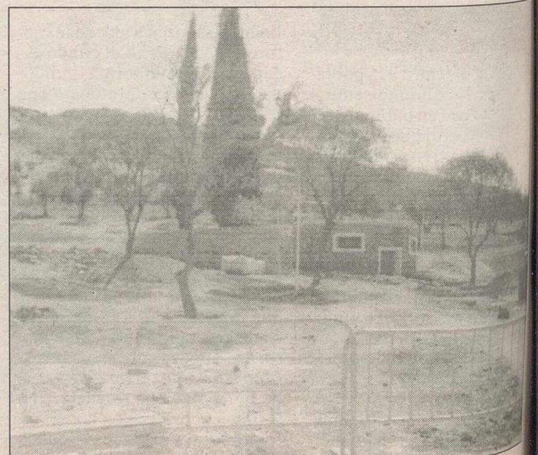
Las obras podrán continuarse con el dinero de la Junta.
