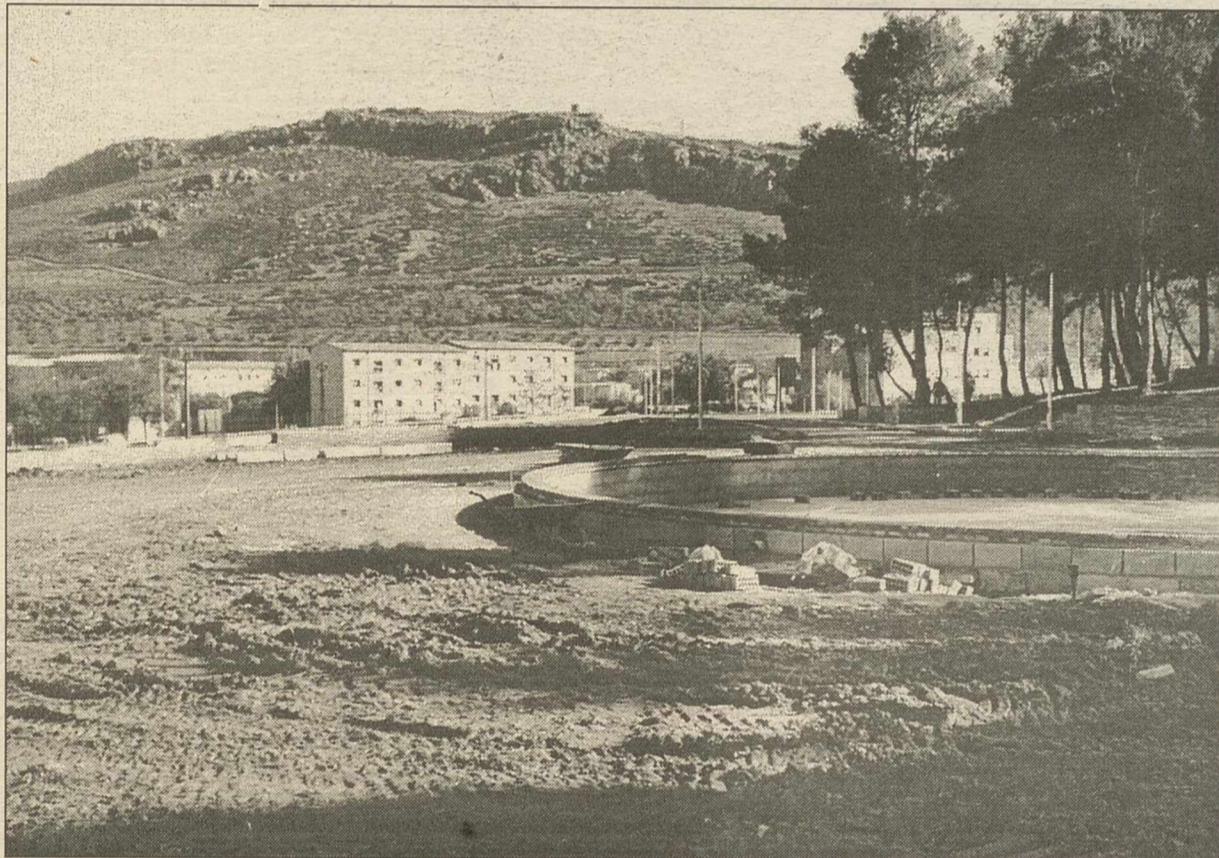
Una imagen del parque de la Rincona en obras
