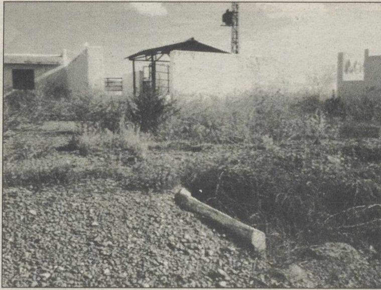
Vista general del aspecto de abandono que presenta el polígono ganadero.
