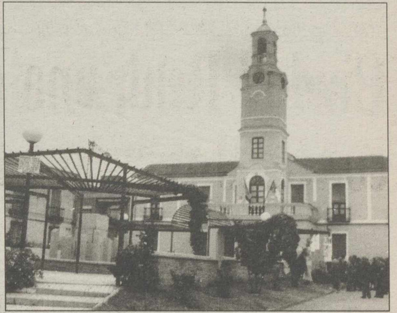
El Ayuntamiento de Malagón dio luz verde a las obras del centro de salud
