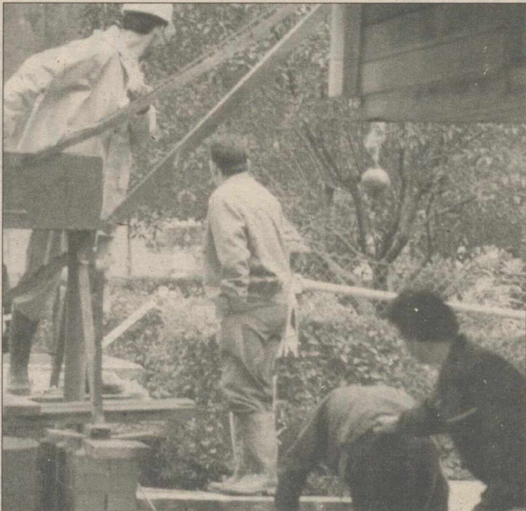
Un aspecto de las obras que estaban llevando a cabo los trabajadores.
