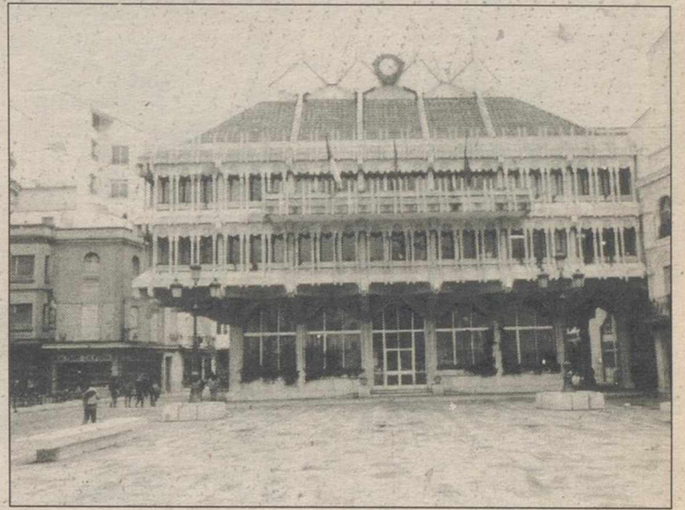
El TSJ falla contra el Ayuntamiento de Ciudad Real.
