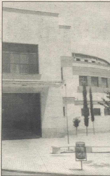
Cerrada la planta baja.
