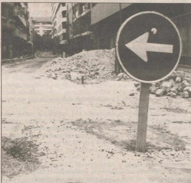
Las obras comenzaron a principios de agosto
