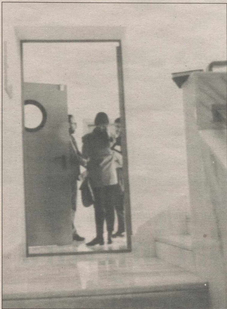
Nada indica, al bajar la escalera, que esta es la salida de emergencia. RUEDA.
