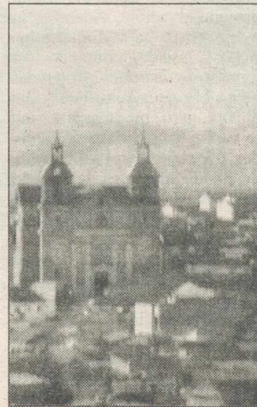
El accidente ocurrió en Piedrabuena.
