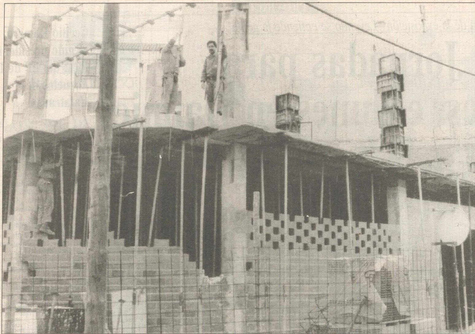
La vivienda, uno de los capítulos en los que más subió el IPC.
