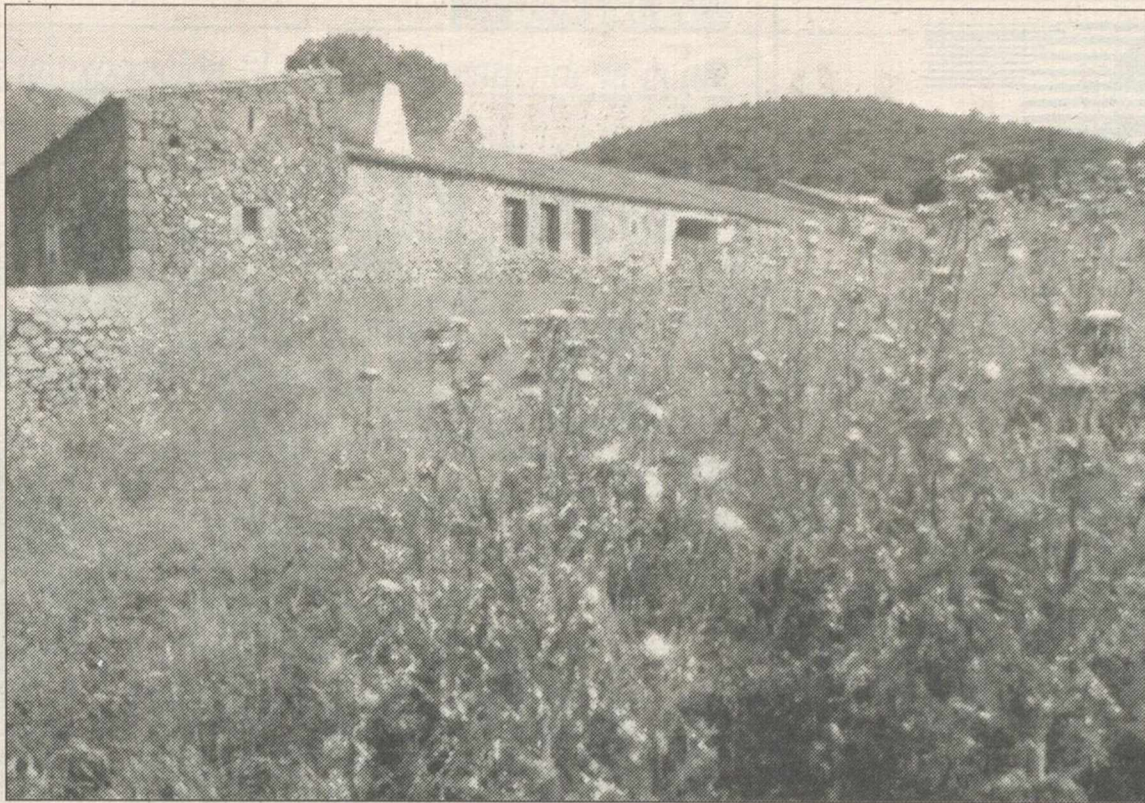
Las casas de alojamiento de las rutas turísticas rurales quedarán rehabilitadas en primavera.
