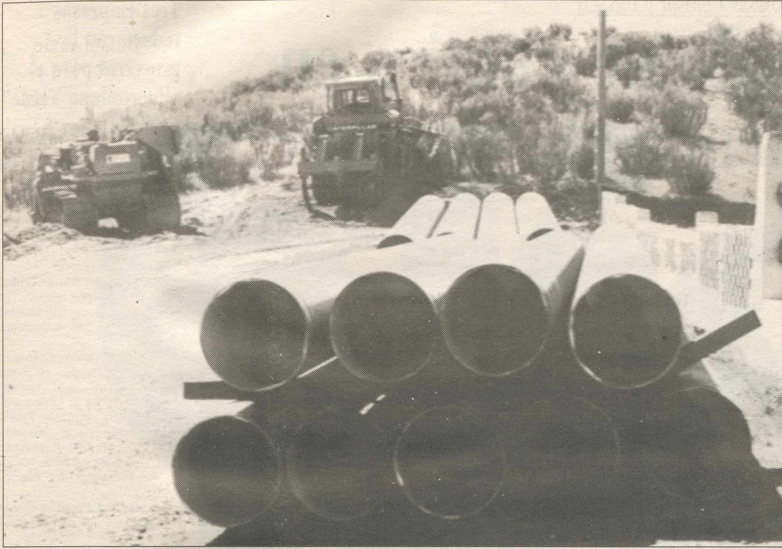
Las obras del trasvase Jándula-Montoro comenzaron en julio
