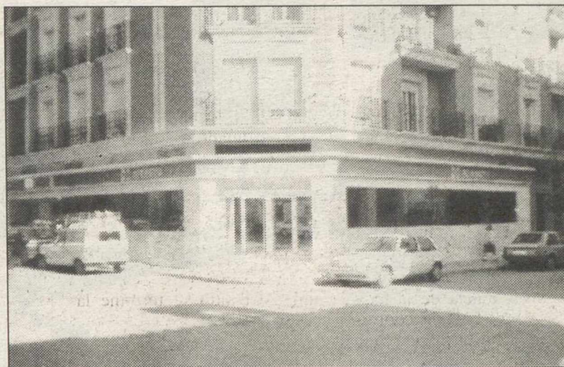
FACHADA ASEPEYO VALDEPEÑAS
