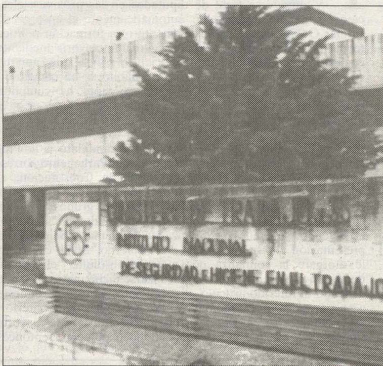
Edificio del Gabinete Técnico de Seguridad e Higiene
