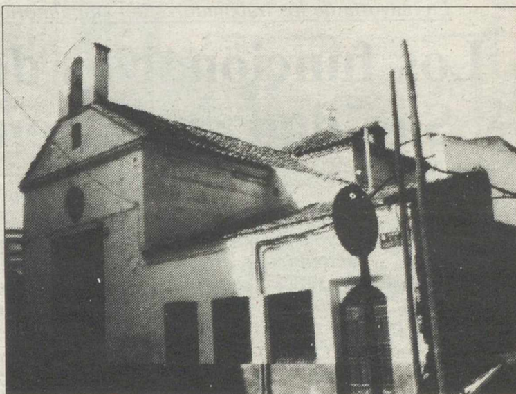
Actual estado de la ermita de los Remedios
