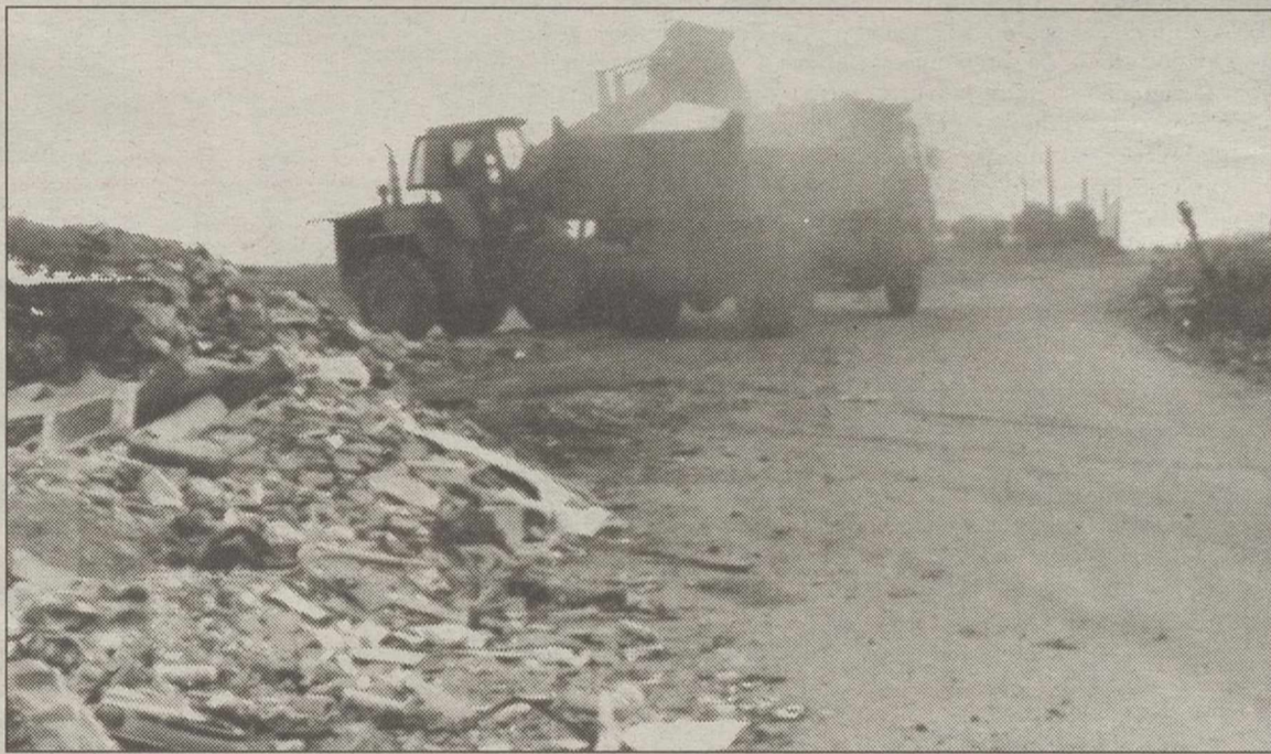
El Ayuntamiento ya ha comenzado a limpiar el camino de Calatrava.
