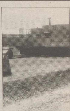
Obras en una carretera.
