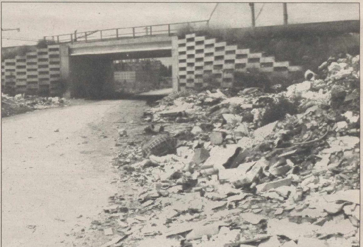
Aspecto que tenía el camino de Calatrava hace unas semanas
