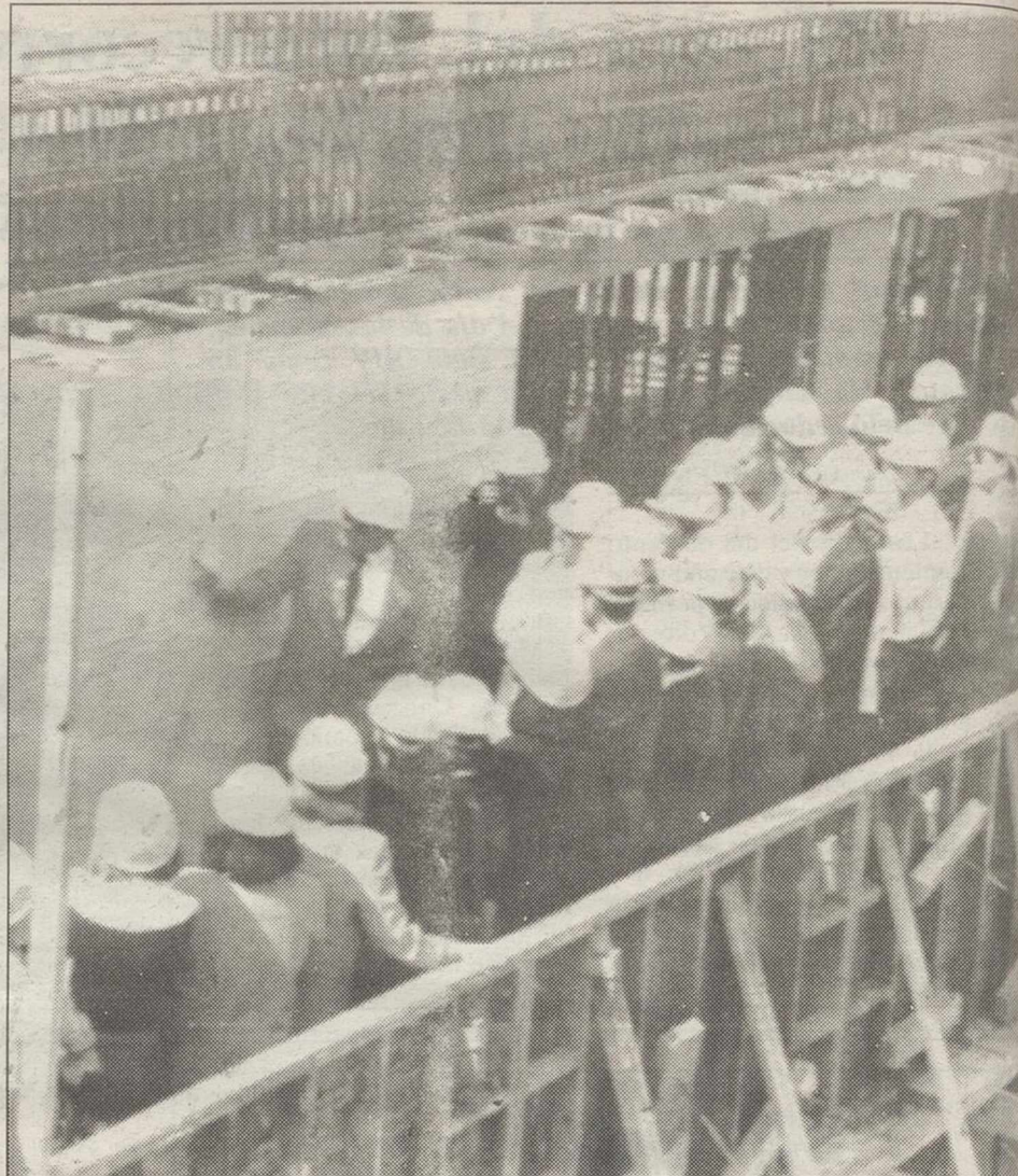
CANDI En la visita a las obras fueron explicados todos los detalles.
