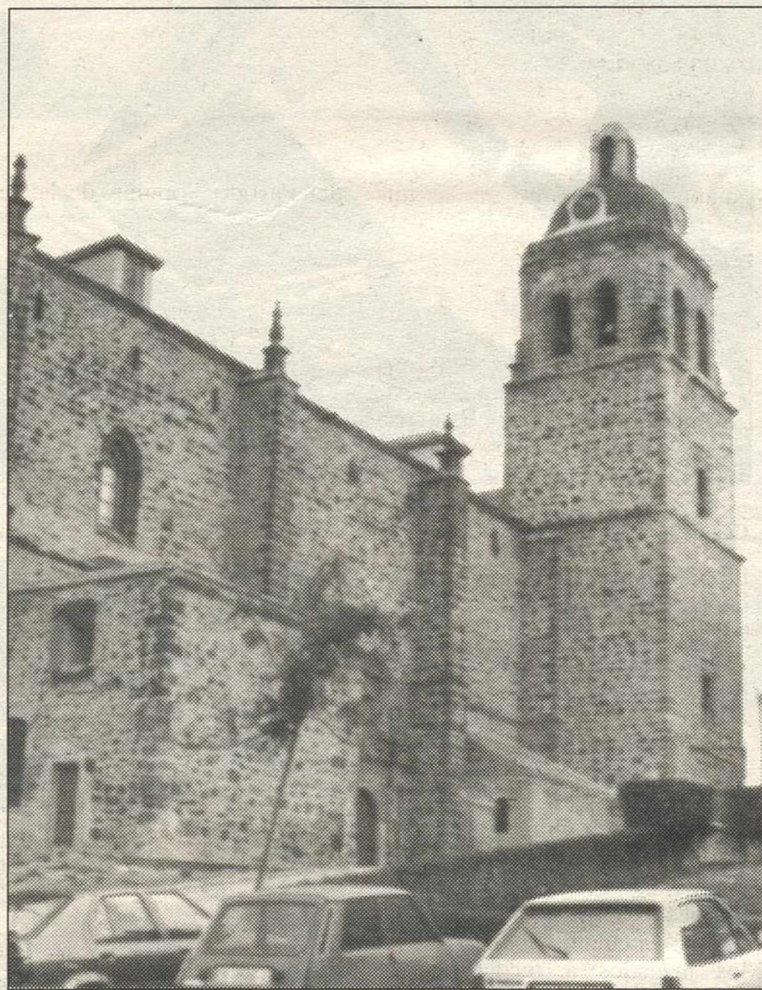
Durante las obras se retiró la estatua del Sagrado Corazón de la torre para demoler la bóveda y la estructura de madera y cubrirla de pizarra.
