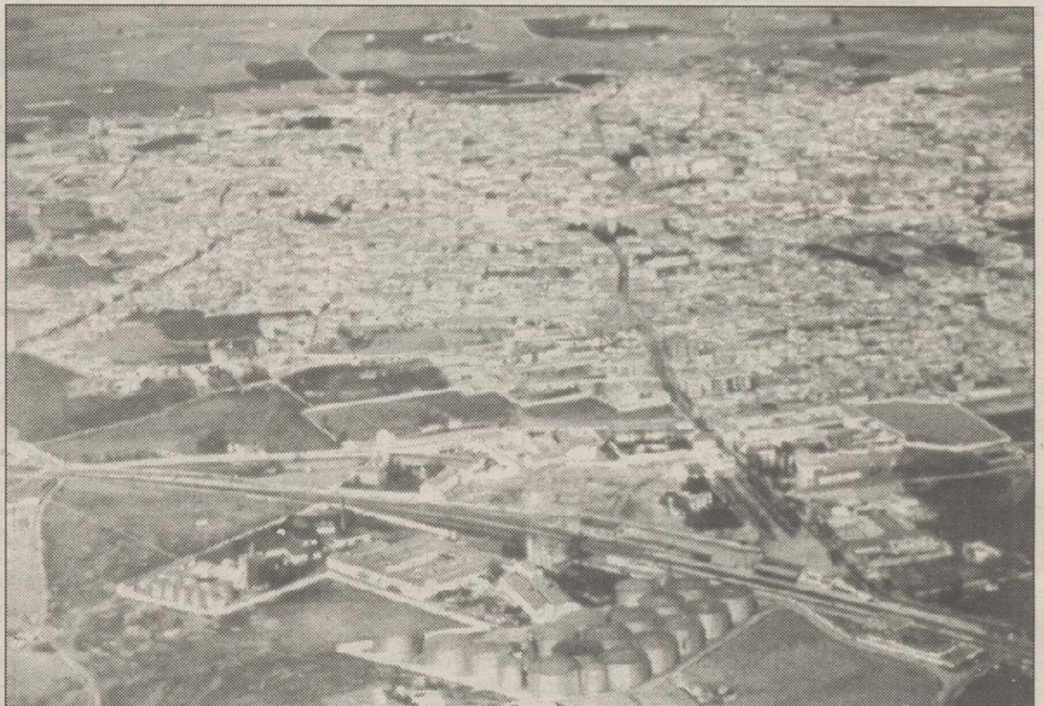
Daimiel tendrá en un plazo de cinco años un polígono industrial
