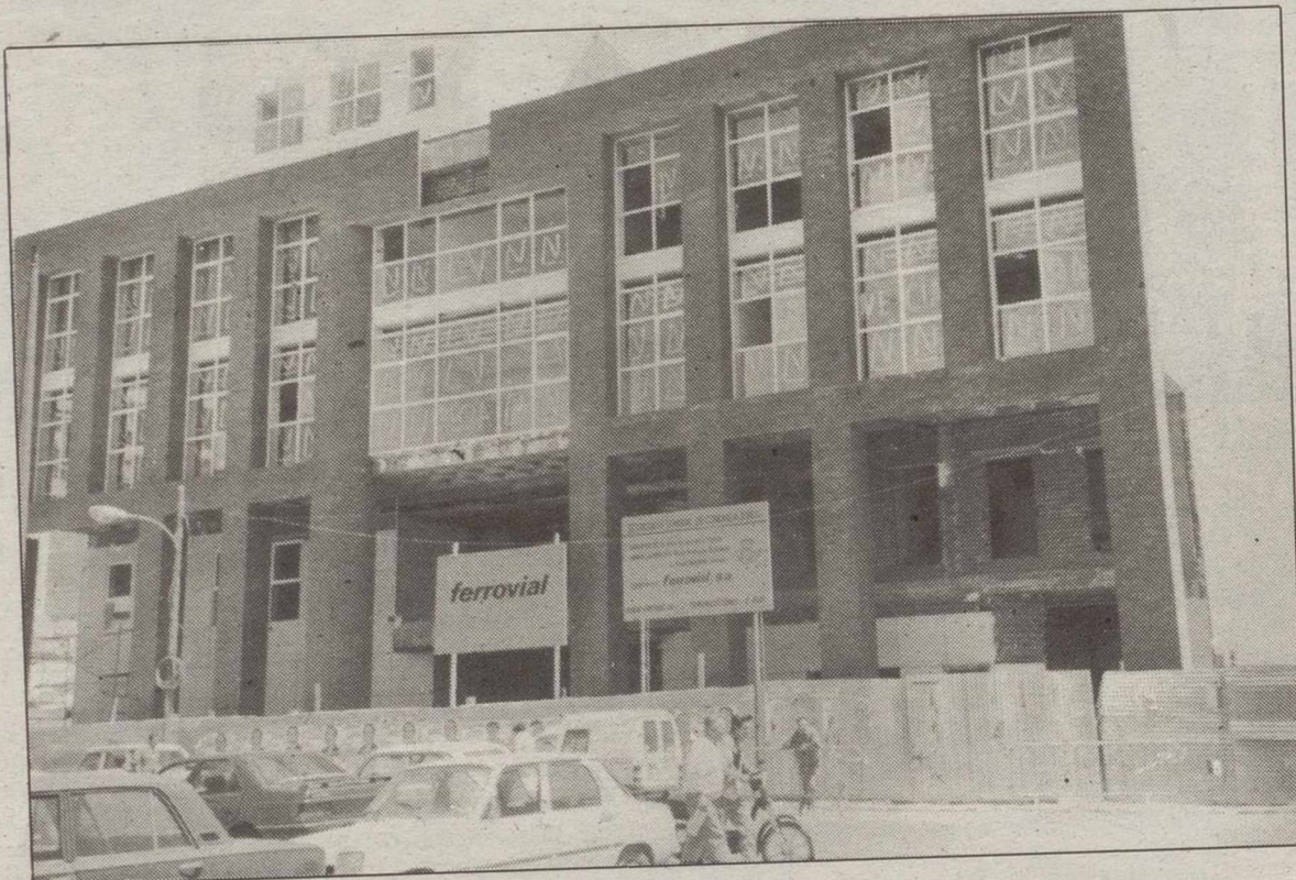
El nuevo ¿palacio? de Correos, que parece no se ciñe al proyecto original, ofende al de la Diputación.
