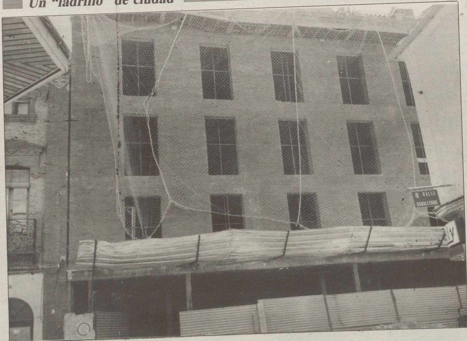
Este mamotreto de ladrillo "típicamente manchego" se levanta en la calle Feria.
