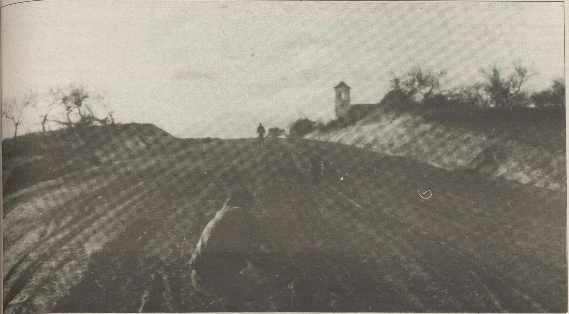
Llano de la Consolación, a la derecha de las obras está la boca del horno.
