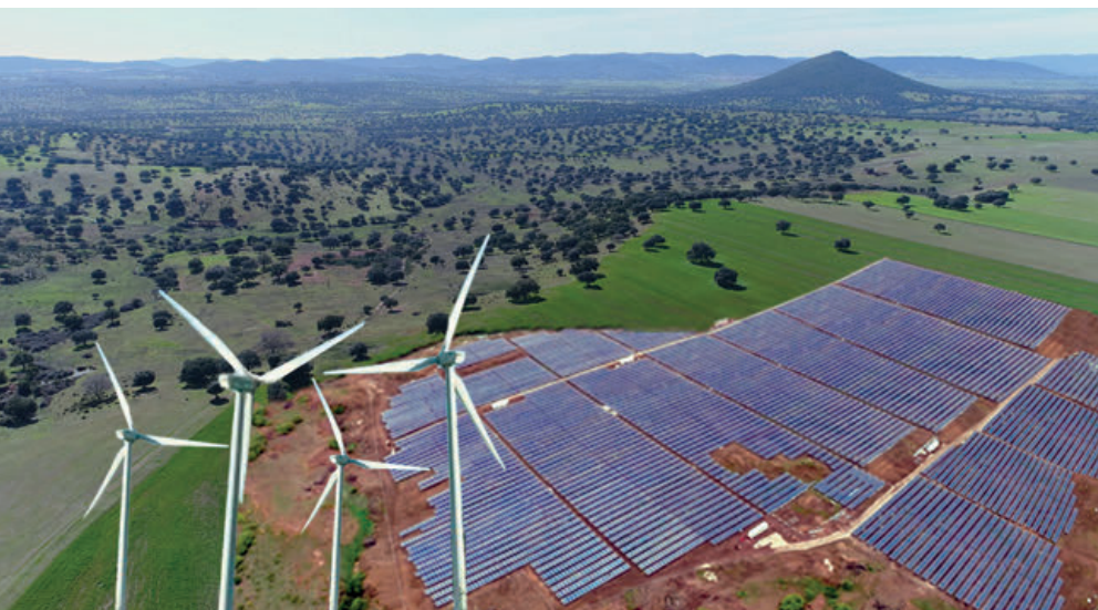
Montaje de parque fotovoltaico en Agudo (Montes de Ciudad Real). Fotomontaje: Raquel Ramiro. Fotografía: Jose Antonio Palomares.
