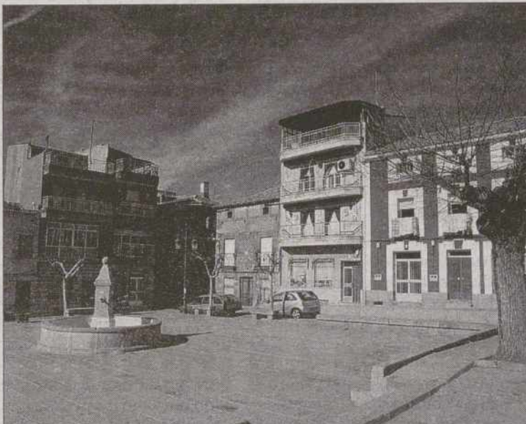
Bodas cree que las obras del centro comenzarán en un año y medio. / R. VIADERO
