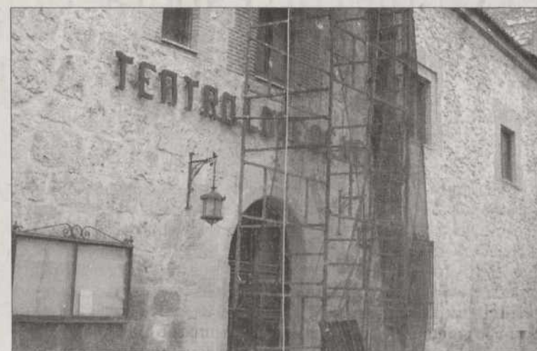
El recinto ha permanecido cerrado desde octubre. / I.V.
