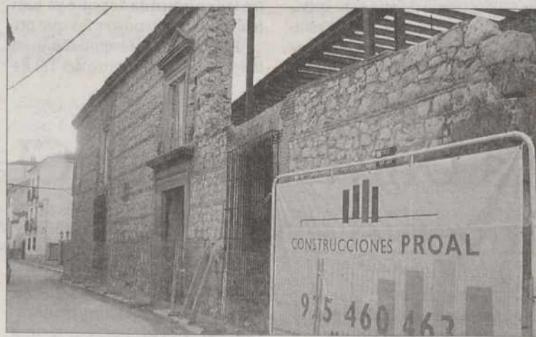
Se pretende rescatar el patio central, columnas y artesonados. / I.V.
