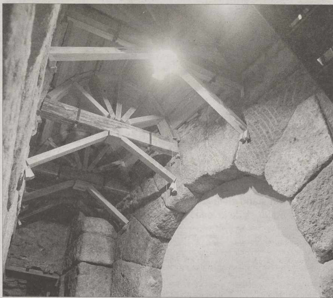
El espacio -depósito romano- tuvo que ser reforzado para la correcta intervención arqueológica. / VÍCTOR BALLESTEROS
