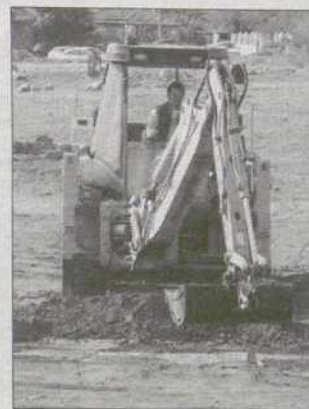
Las máquinas trabajan ya.
