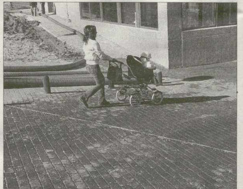
La rampa es peligrosa para los vecinos y vehículos que la usan. /DAVID PÉREZ
