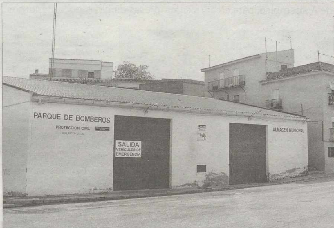
El Servicio Municipal de Extinción de Incendios podría distribuirse en tres equipos para cubrir un servicio permanente. / I.V.
