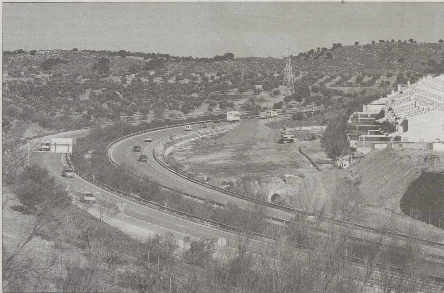
Los vecinos reclaman el exceso de ruido que provoca la autovía. / VALDIVIELSO
