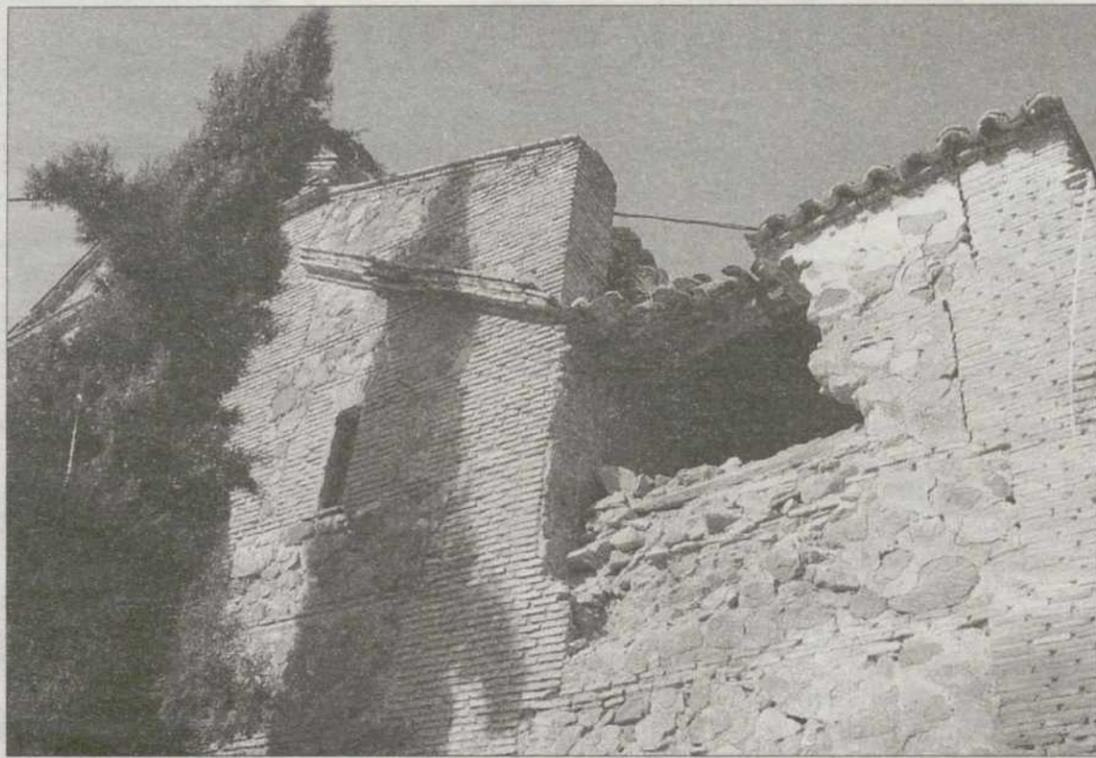
La caída de parte del muro de la fachada principal pone en peligro la estructura de todo el edificio. / JESÚS ORGAZ
