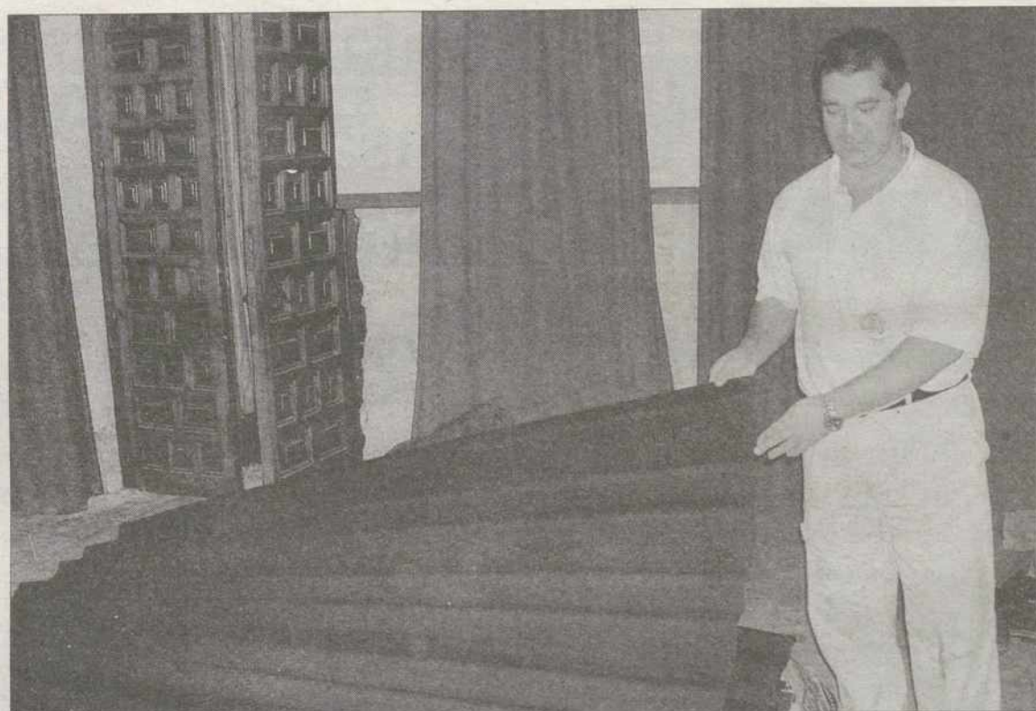
Antonio Cobo, uno de los encargados de los trabajos, muestra las láminas bituminosas que impermeabilizarán las cubiertas. / I.V.
