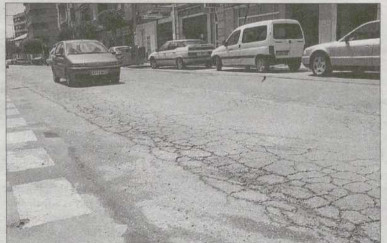
La carretera de Gerindote será uno de los ejes que se mejorará. / N.N.
