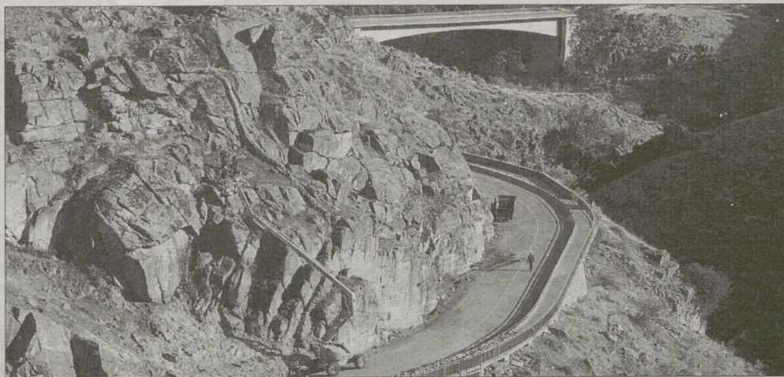
Las obras de la carretera del Valle ya están en marcha. / YOLANDA REDONDO
