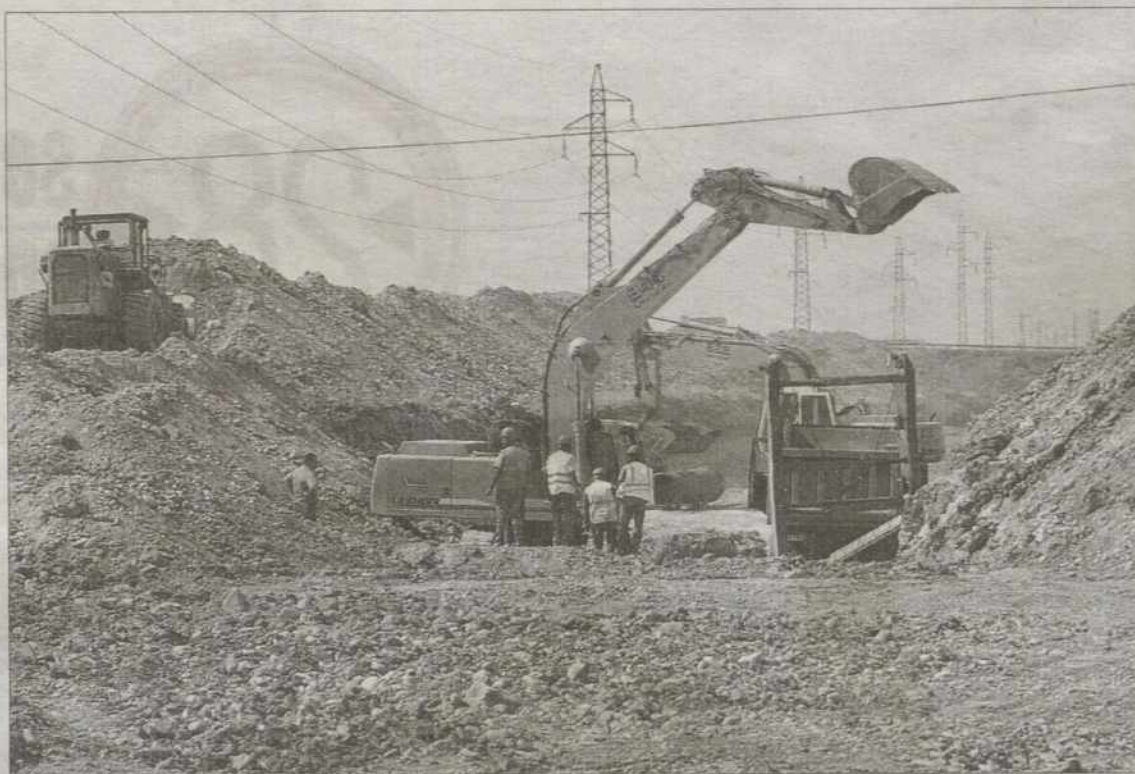
Para colocar las tuberías del colector es necesario abrir una zanja de doce metros de ancho. / R. VIADERO
