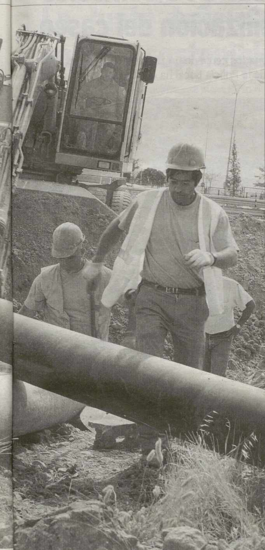
Los operarios han instalado ya 1,2 kilómetros de tubería. / R. VIADERO
