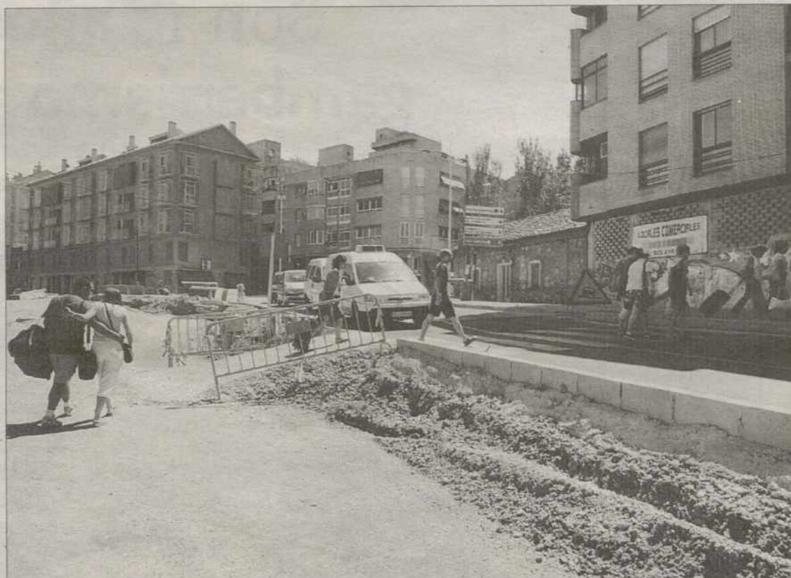
El entendimiento entre las administraciones debe agilizar el final de las obras del Paseo de la Rosa. / YOLANDA LANCHÁ
