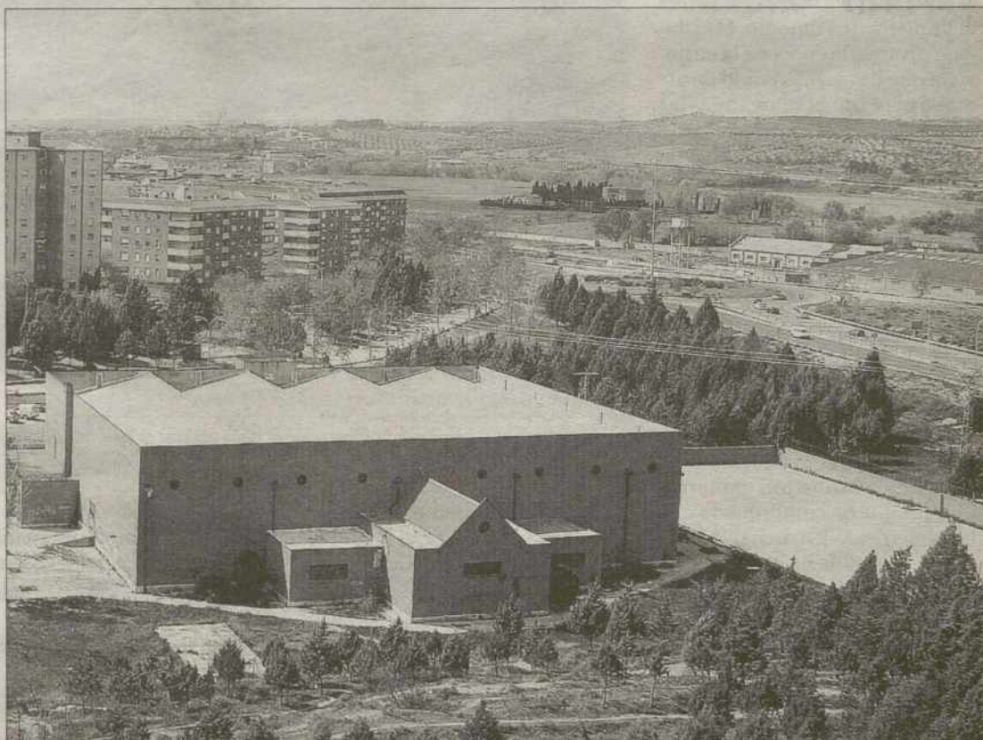
La zona conflictiva, tras el pabellón de Santa Bárbara./YOLANDA LANCHÁ
