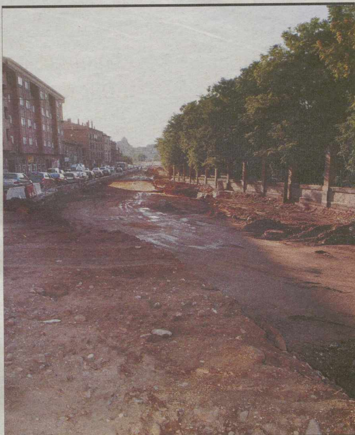
Vista de las obras en el Paseo de la Rosa, junto a la reja de Julio Pascual. / VÍCTOR BALLESTEROS
