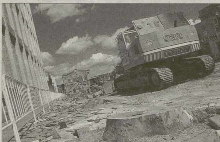
El paseo de la Estación tras los primeros días de obras. / MANU REINO
