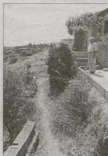
Una caída sin barandilla.
