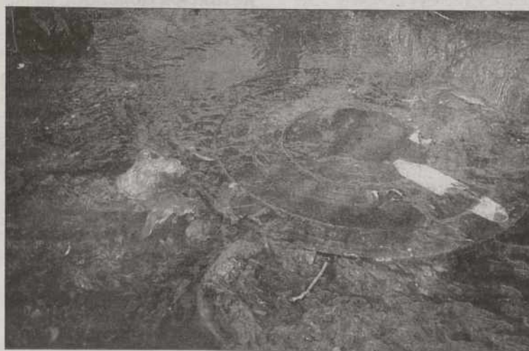
La obstrucción de la alcantarilla ha provocado esta situación. /L.T.
