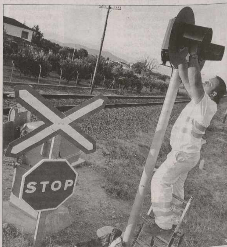
La instalación del sistema de barreras automáticas acabó el martes./R. VIADERO
