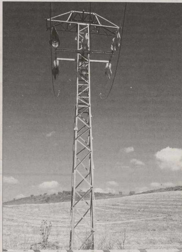
Las crucetas, en la zona superior de las torres eléctricas, sirven de posadero. / Y.L.
