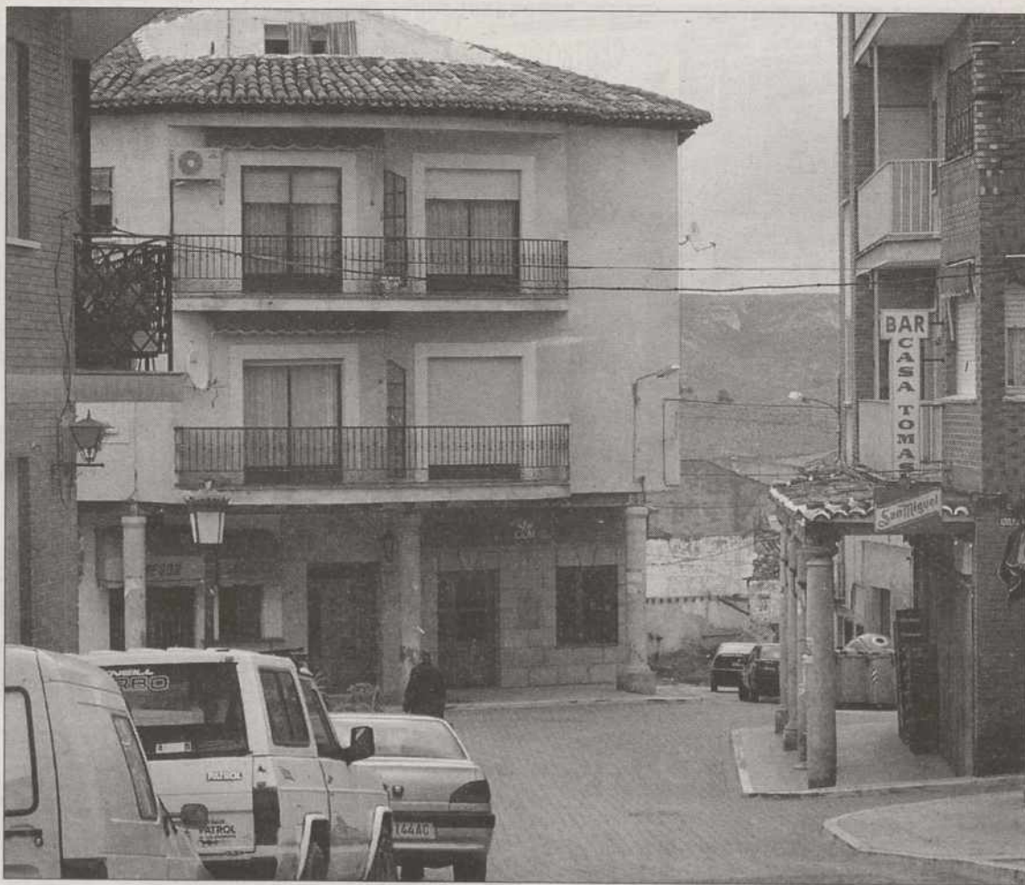
Desde esta calle, junto al Ayuntamiento, se accede a la zona a recuperar. / I. V.
