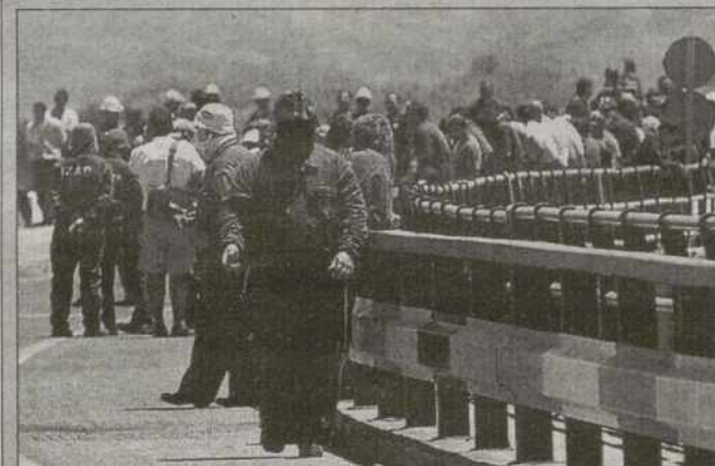
Varios trabajadores de Izar cortan un puente en Cádiz. / J. M. (EFE)
