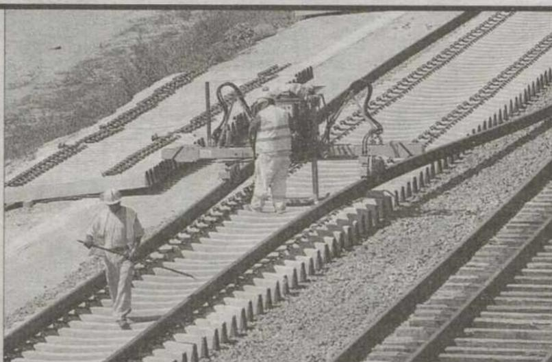
**Colocación.** Los carriles se colocan sobre las traviesas, se comprueban con precisión milimétrica y se fijan. / Y. LANCHA
