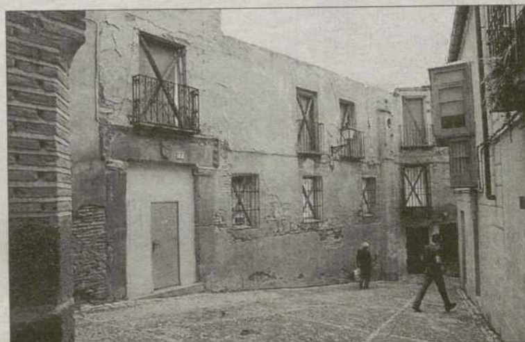
Exterior del solar.
