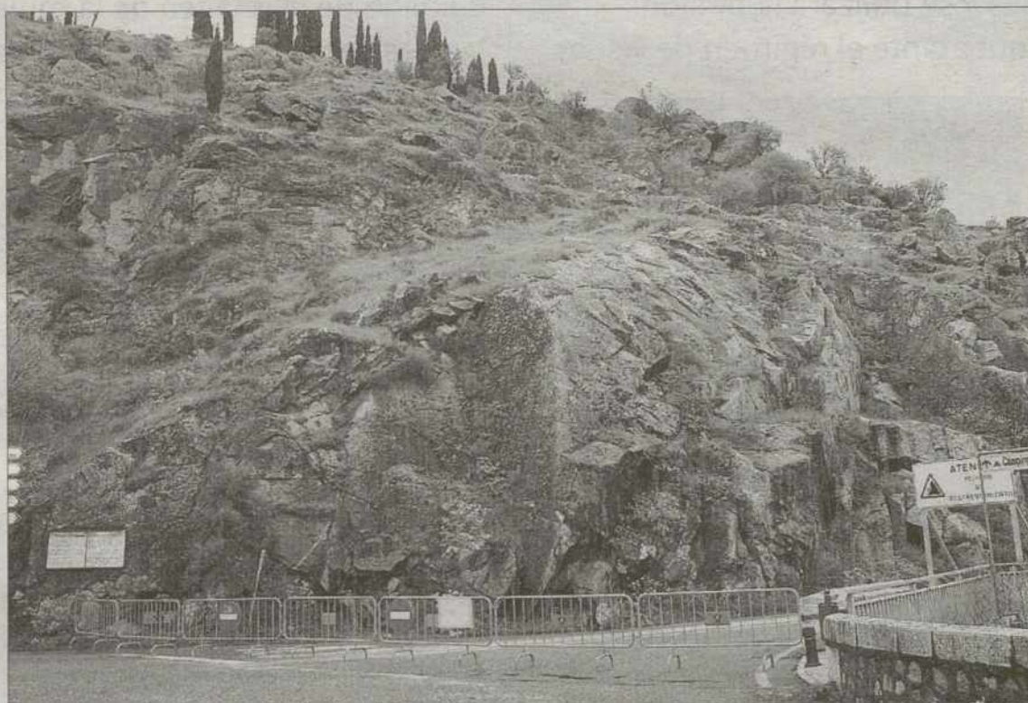
Estado actual que presenta la carretera del Valle. /DAVID PÉREZ
